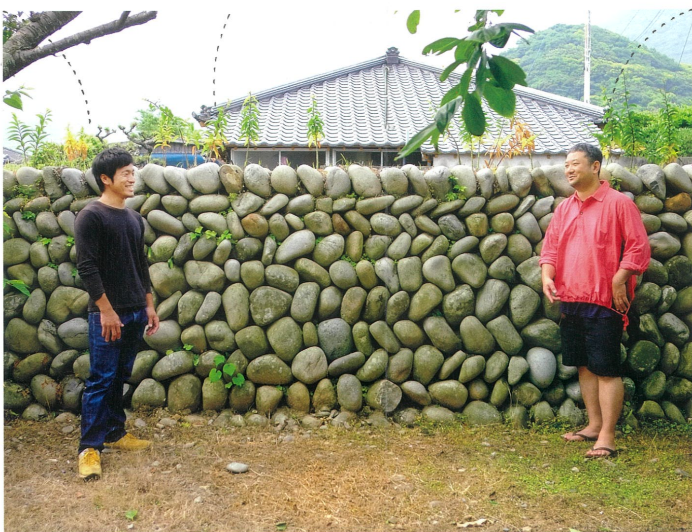
失われつつある玉石の町並みを取り戻すべく、山下さんが2008年に立ち上げた「たまいしプロジェクト」で、島民や地元出身の学生などが集まり再生した玉石垣。島内外からの13人で10日かけて作業を行った
